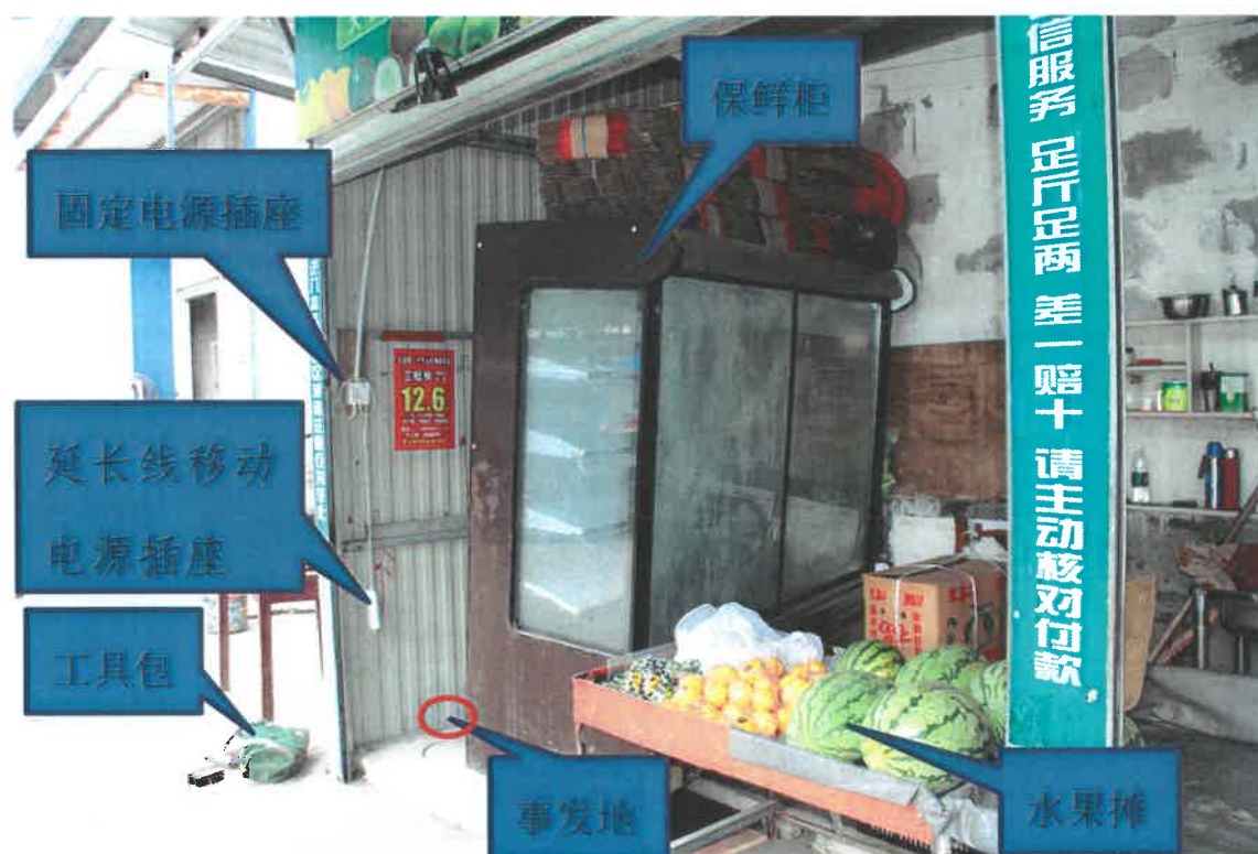
事故现场照片四：维修压缩机时保鲜柜位置状况
